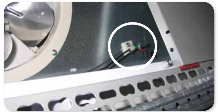
同一の温度/圧力値を測定するために全センサーの台数を2倍にします
